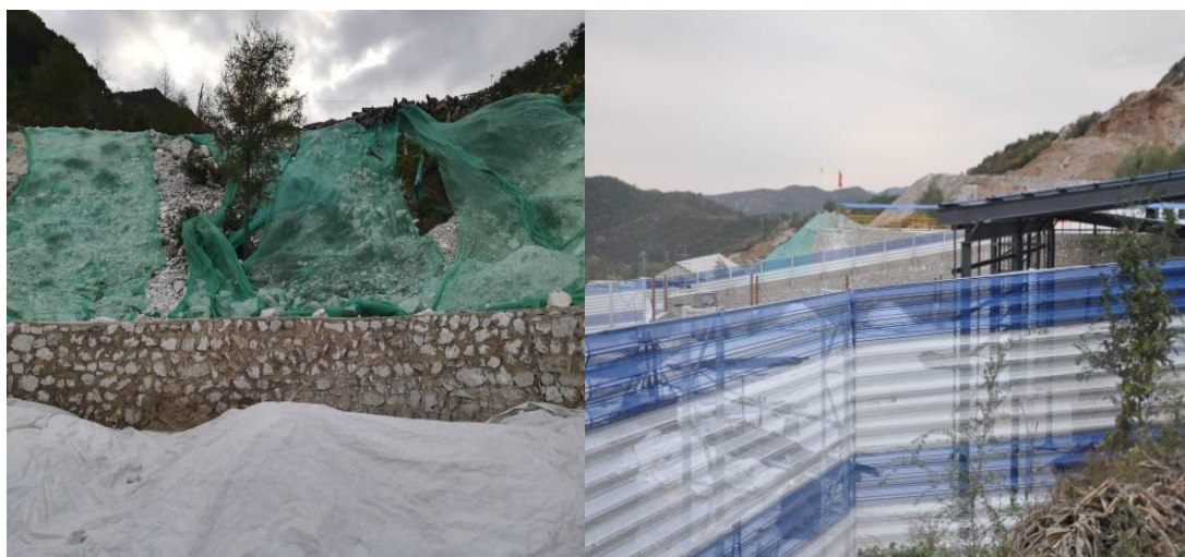
工业场地临时防护措施
