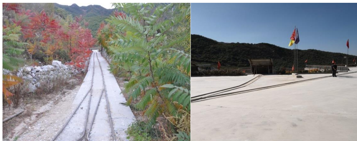
工业场地排水沟、绿化、硬化
